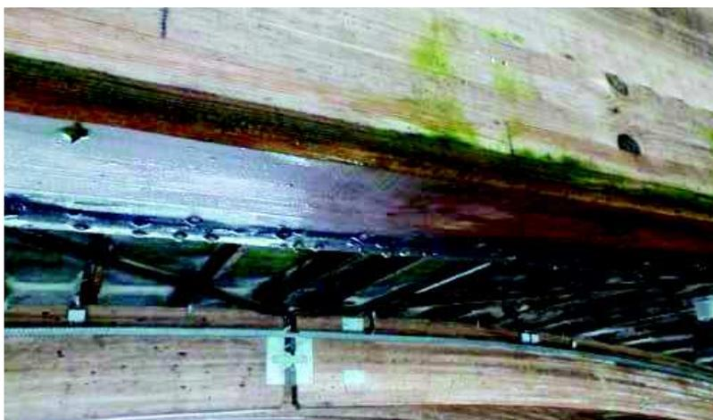
◀ Massive Kondensatbildung an der Trägerunterseite
