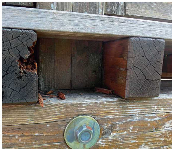
▲ Im Hirnholz- bereich geschädigte Querträger
