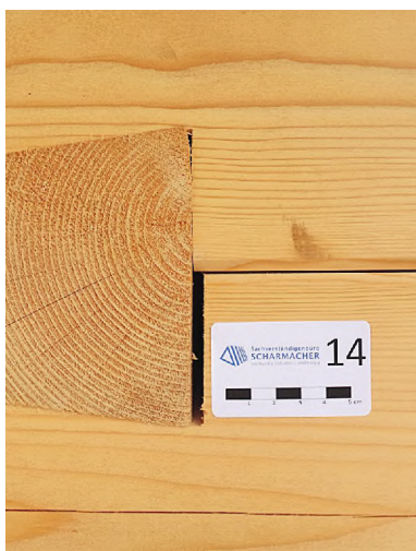
◀ Beispielhafte Eckverkämmung mit Ausführungsungenauigkeiten
