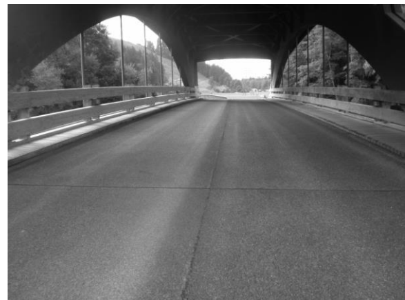
Abbildung 14: Fahrbahnbelag der Bubeneibrücke nach der Sanierung
