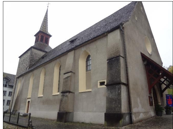
Abbildung 12: Außenansicht der Nordseite
