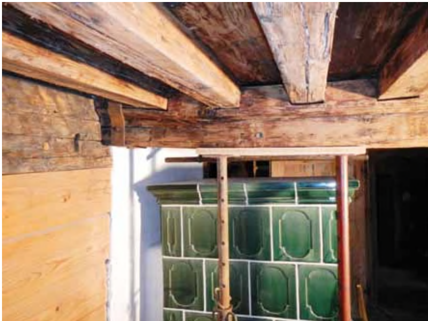
Verformter und unterseitig gerissener Unterzug der Stubendecke, mit Abstützungen
