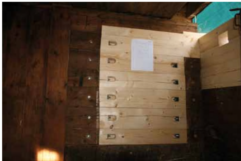
Verschluss der Öffnung in der östlichen Binnenwand
