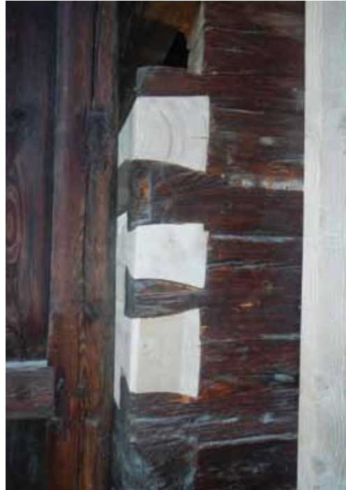
Ausgeführte Eckreparatur in der Nordostecke, individuell angepasste Holzgeometrie
