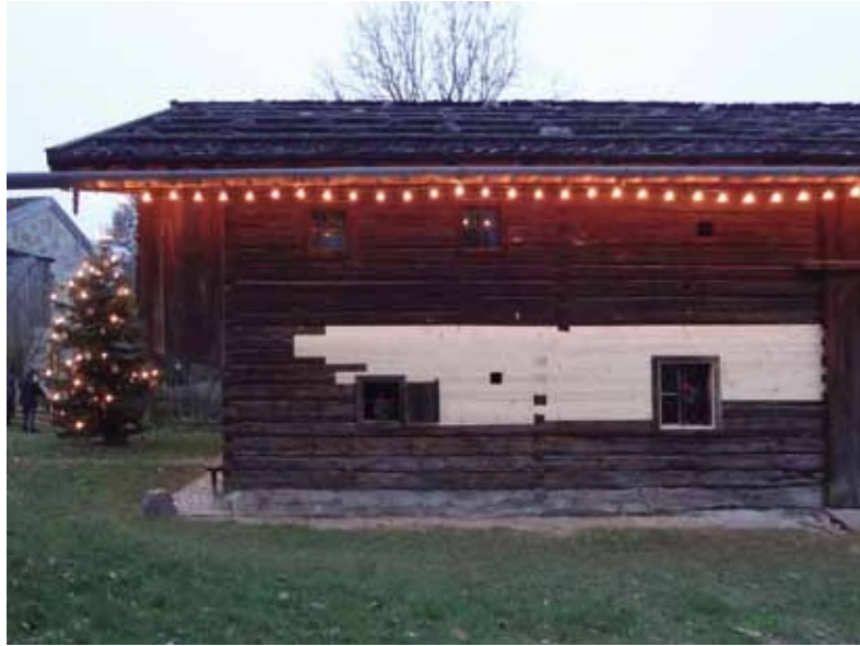
Östlicher Block nach Fertigstellung der Instandsetzungsarbeiten
