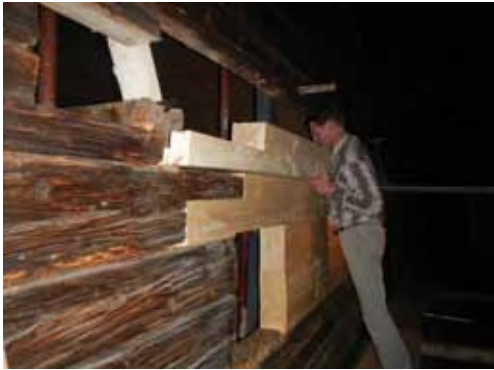
Ausführung der Arbeiten bei der Reparatur der östlichen Blockwand
