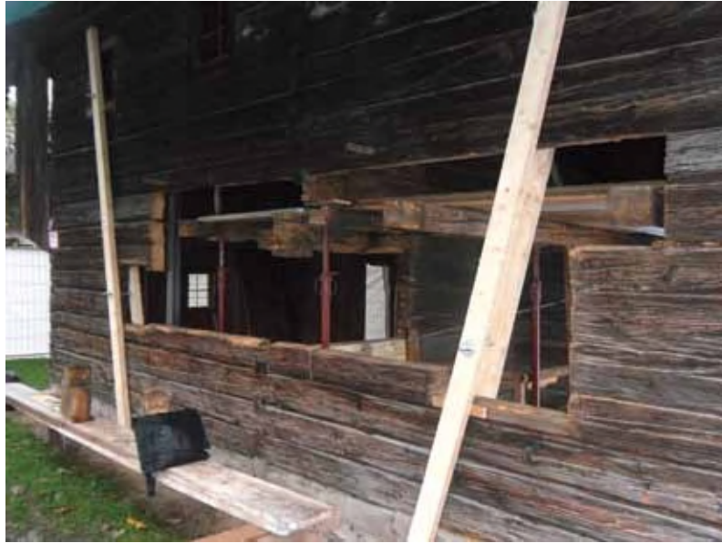
Zustand der östlichen Blockwand nach Einrichtung der Bauzustandssicherung und Ausbau der schadhaften Balken
