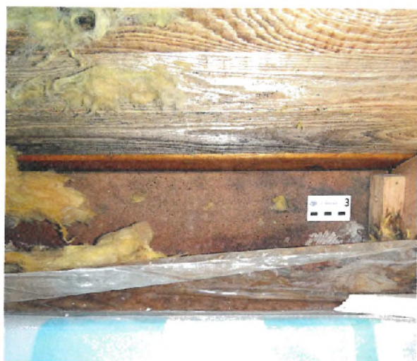
▲ Übergang Wand/Dach ohne Verklebung der Folienstöße
