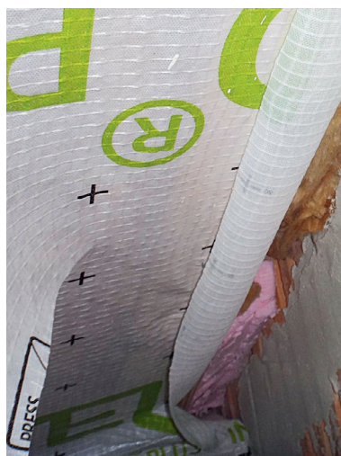
▶ Fehlende Abklebung der Dampfbremsfolie
