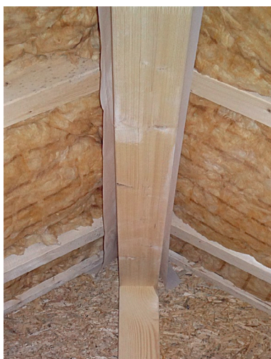
◀ Zwischen-sparrendämmung ohne Dampfbremsfolie
