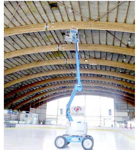
(6) Handnahe Überprüfung einer Eishalle mittels Hebebühne
