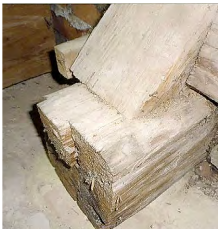
(8) Beispiel eines nicht ausreichenden Vorholzes am Knotenpunkten Sparren/Zerrbalken
