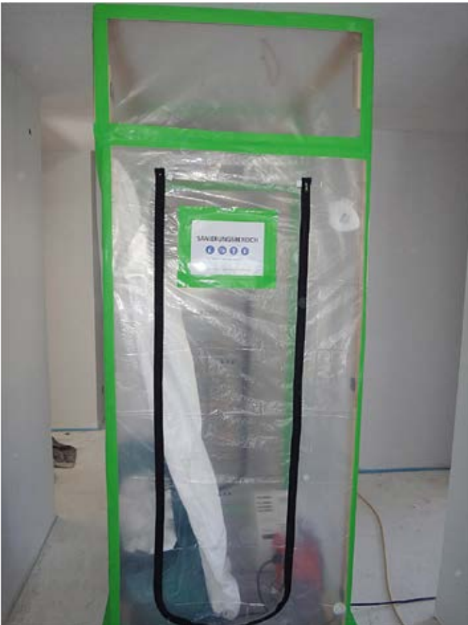
Abb. 5: Schleuse eines Schwarz-Weiß-Bereichs zur Schimmelpilzsanierung. Diese dient zur Abschottung des schimmelbelasteten Sanierungsbereichs zur restlichen Baustelle, um eine Verschleppung von Sporen zu verhindern bzw. zu reduzieren.
