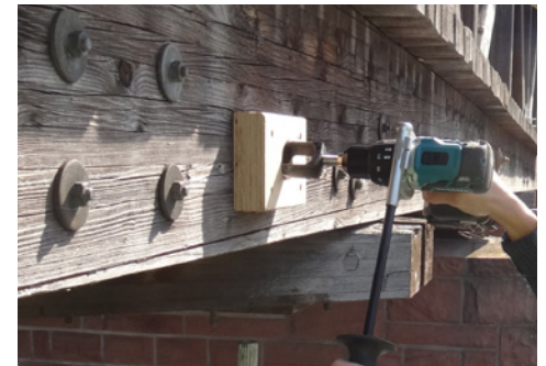
Abb. 3: Führung des Zapfenbohrers / Scheibenschneiders mit einer Bohrschablone
