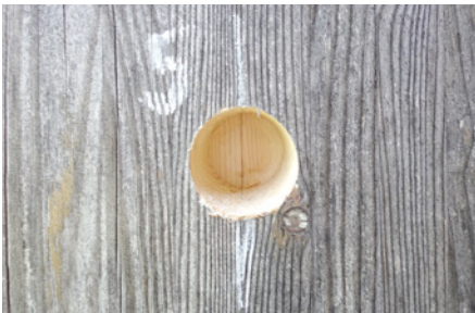
Abb. 1: Entnahmestelle in einem BS-Holzbauteil
