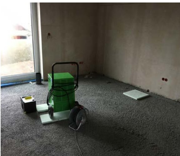
▲ Gebundene Splittschüttung nach dem Einbau
